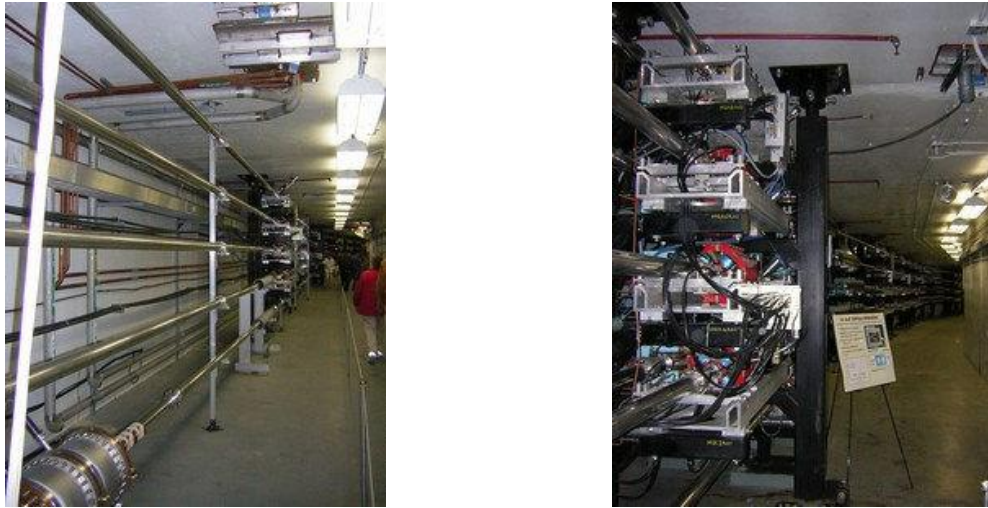
Figura 10.1- Fotografías del túnel del acelerador de electrones del JLAB (Newport News, USA). Se aprecian los cinco distintos recorridos que realiza el haz de electrones en función de su energía.
